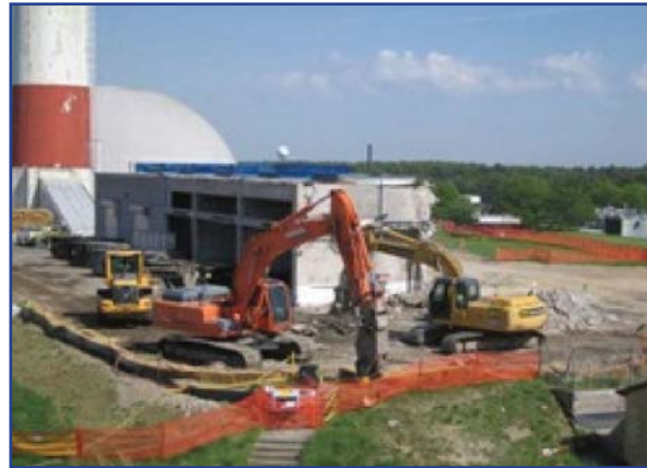
Fan House demolition
