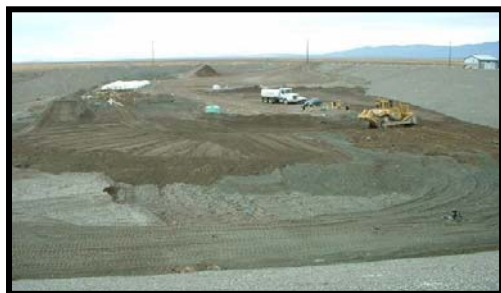
CERCLA Disposal Cell
