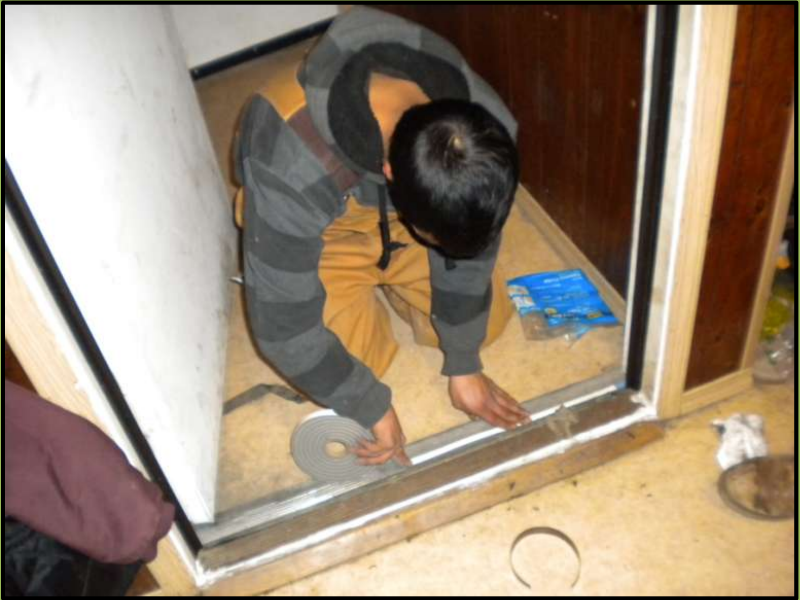
Sealing doors, installing door sweeps and door jams
