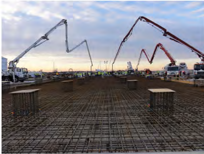
Concrete Pour 131N (14-Feb-2013)
