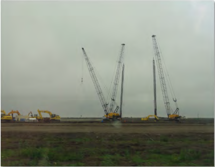
BoMac Piling Rigs (27-Nov-2012)
