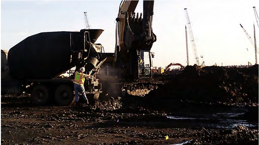
Slurry Pour to a Mix Grid (14-Jan-2013)
