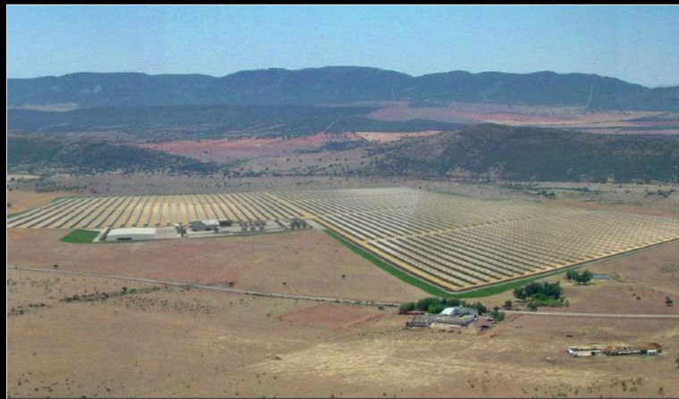
50 MW Iberdrola Energia Solar de Puertollano Puertollano (Ciudad Real)
